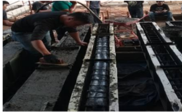
Gambar 6. Pengecoran benda uji
